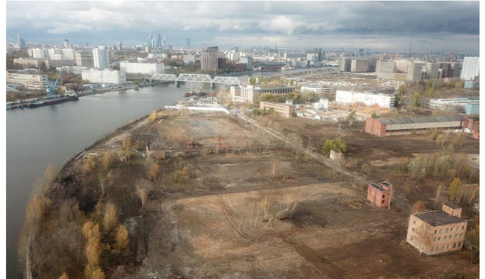
2020 год Подготовка территории строительства южной части территории ЗИЛ
